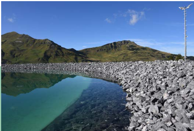
Fig. 4: L'enrochement massif des rives exondées, comme ici à Planachaux/Champéry exclut toute valeur écologique végétale ou animale, même du côté amont, accolé à la montagne (photo: P.-A. Oggier). [553.2/114.3–1805m; 18'000m 2 ]
