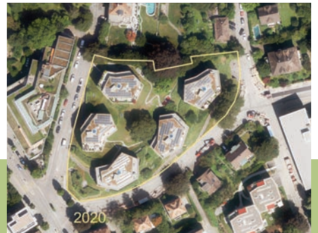
Immeubles de remplacement bâtis selon le régime des constructions dérogatoires spéciales à Zurich (photo: © swisstopo; licence Creative Commons).
