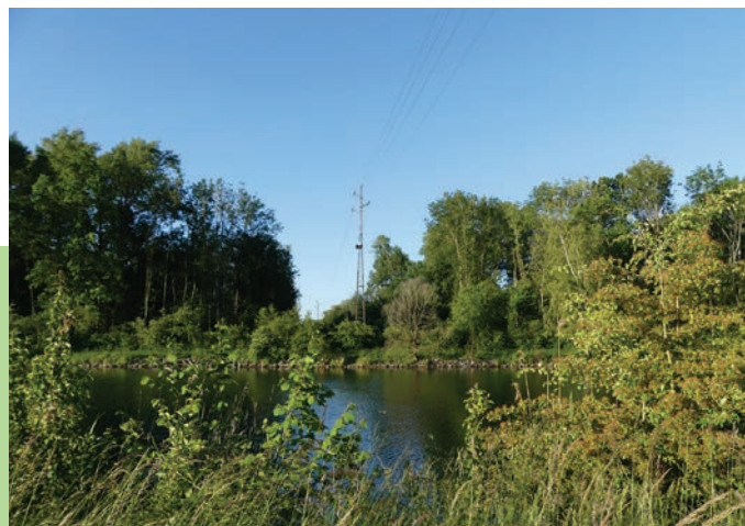
Fig. 2: Portée de la ligne à haute tension de 60 kV Thielle-Cudrefin traversant le canal de la Broye (photo: Alain Lugon).
