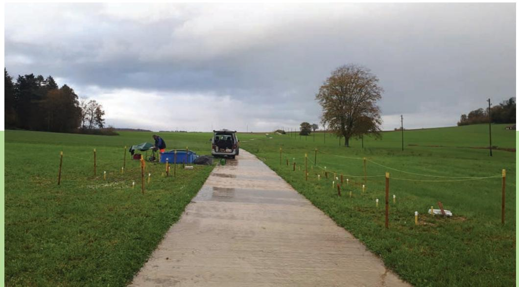
Fig. 2: Chemin en dalles de béton. Les écoulements de surface franchissant le chemin au niveau des barrages sont bien visibles (photo: E. Berdat).
