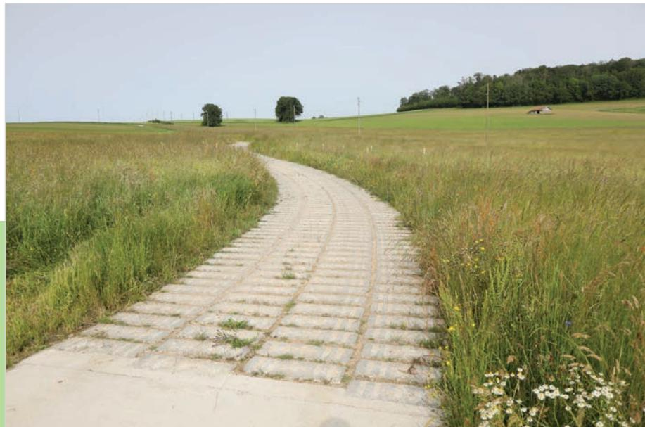
Fig. 1: Détail de la construction du chemin en plots de béton (photo: Ph. Grosvernier).
