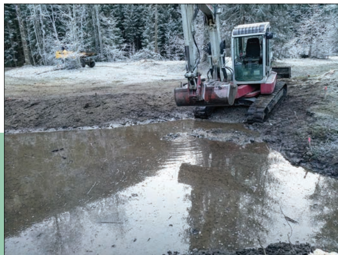
Fig. 2: Construction d'un étang sur un sol gelé à Surava Oislas dans le cadre du projet «connexion des biotopes de l'Albula» (photo: Verein Parc Ela).
